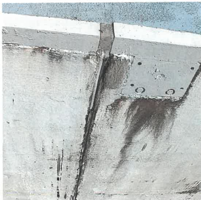
Zdjęcie 18. Wykruszone wypełnienie dylatacji ściany.
