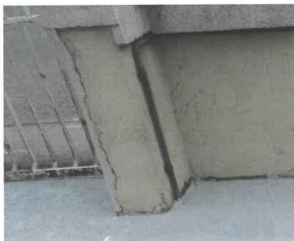
Zdjęcie 11. Ujęcie wody – ślady napraw parapetu
