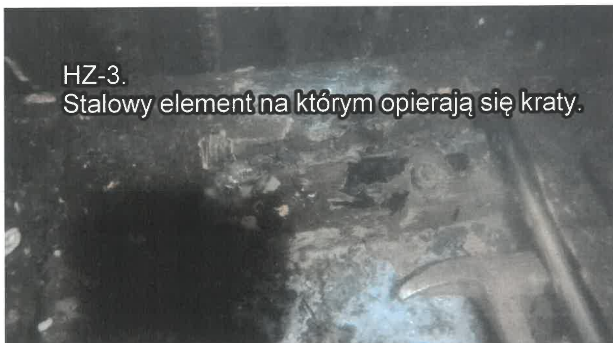
Zdjęcie 25. Ujęcie z podwodnych oględzin betonów. Belka podporowa krat wlotowych (widoczne brakujące elementy).
