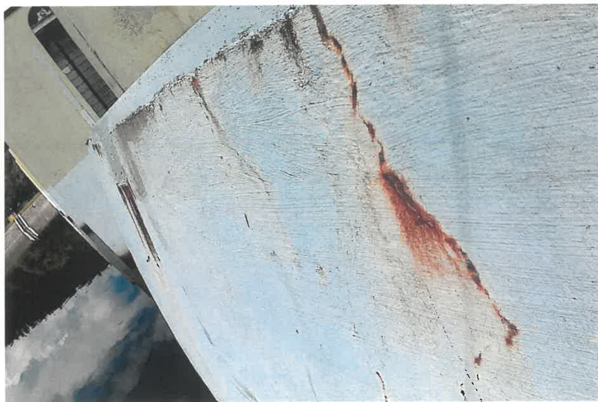
Zdjęcie 17. Ujęcie wody – pęknięcia i zacieki rdzy na ścianie.
