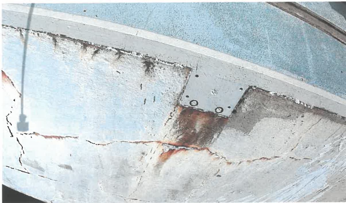
Zdjęcie 16. Ujęcie wody - zaciek rdzy na ścianie odwodnej pod obramowaniem krawędzi nawierzchni.
