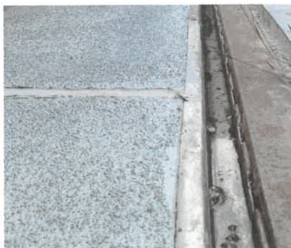
Zdjęcie 5. Zbliżenie na szyny toru suwnicy.
