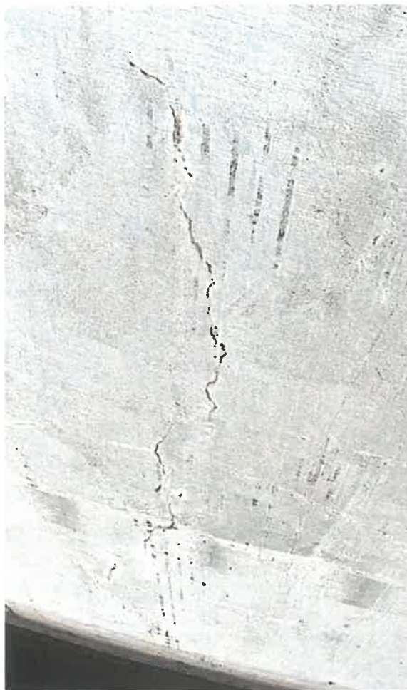
Zdjęcie 15. Ujęcie wody. Pęknięcie pionowe biegnące przez całą wysokość części nadwodnej ściany.
